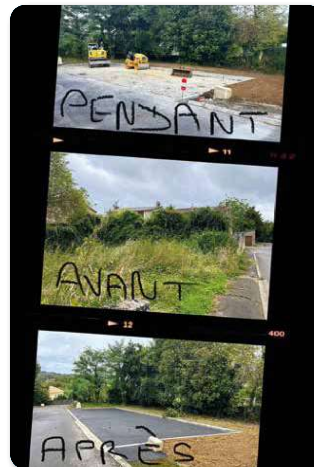
Travaux parking la Guillotière
