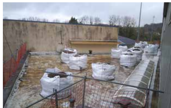
Réfection étanchéité gymnase
