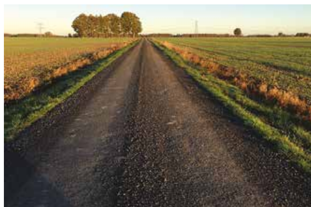
Réfection du chemin des brandes impériales 2.2 km
