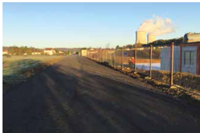
Aménagement du chemin sous le peu pour travaux caserne PSPG (Pelotons spécialisés de protection de la gendarmerie)
