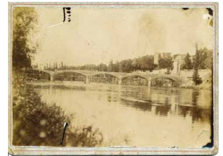
Le pont en construction, 1899.
